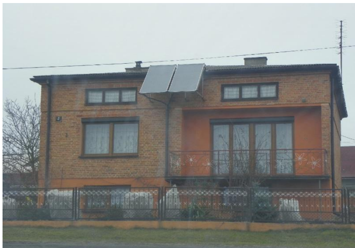
Fig. 3.5. Panele solarne na jednym z domów w Kwiatkówce (6.03.2015 r. fot. Ł. Lelek.)
