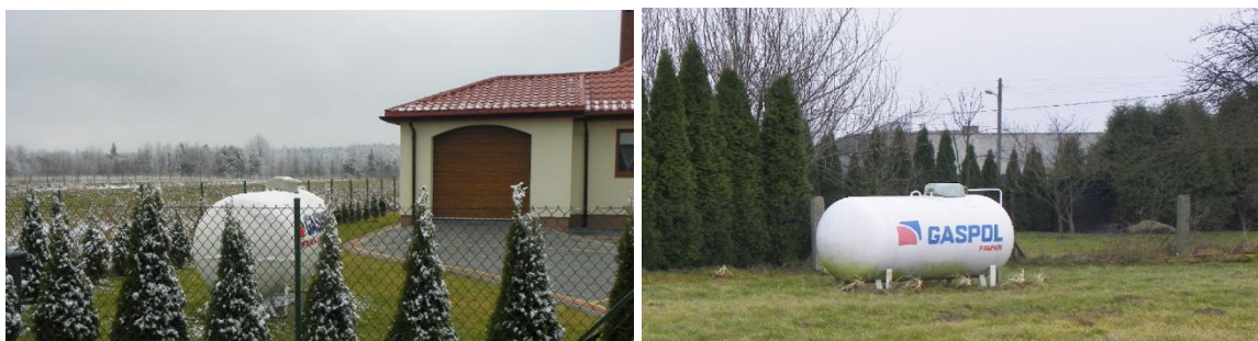
Fig. 2.6. Zbiornik z gazem ciekłym w Wąwale i Chorzęcinie
